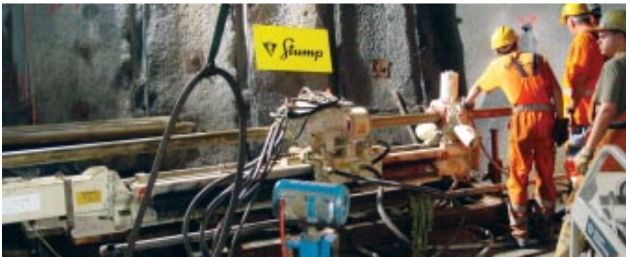
Galleria Mitholz: sondaggi in orizzontale
