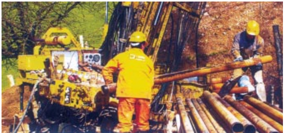
Sissach: sondaggio geognostico galleria Chienberg
