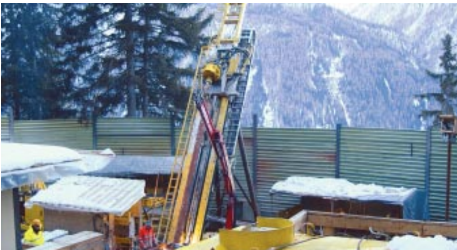
Tunnel de Mitholz: forages horizontaux (450 m)
