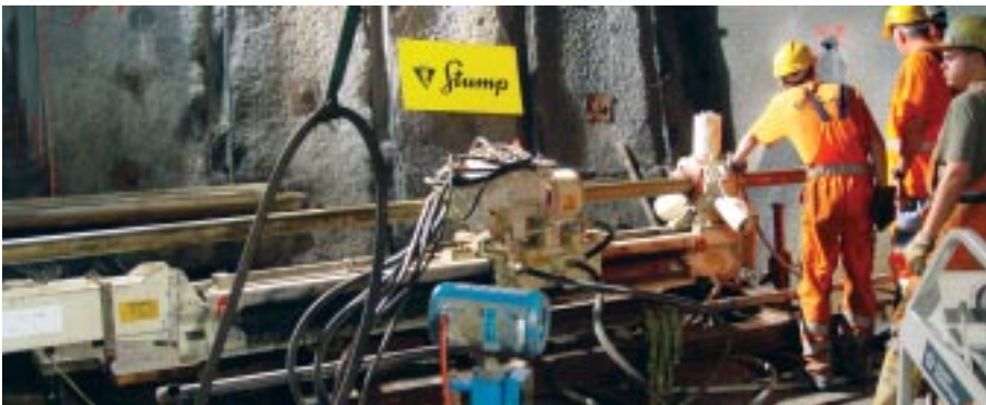
Tunnel de Mitholz: forages horizontaux (450 m)
