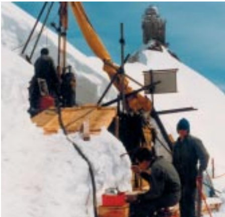
Jungfrauoch: forage en permafrost
