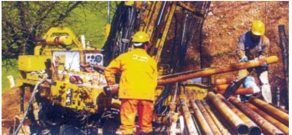
Sissach: forages au tunnel de Chienberg
