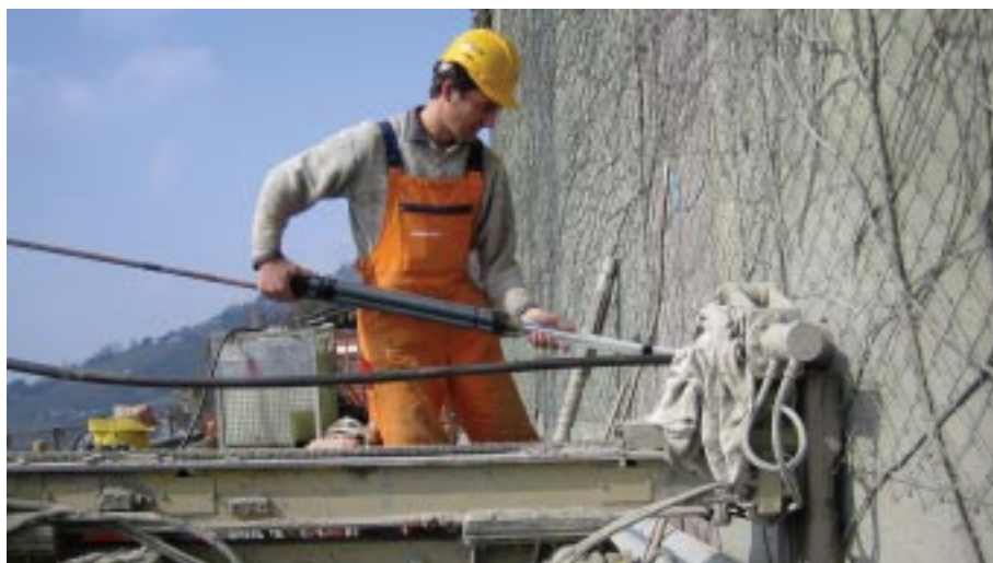
A9 - Chexbres: Pose d'un extensomètre de forage multipoints
