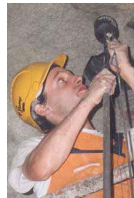
Installazione di un estensimetro
