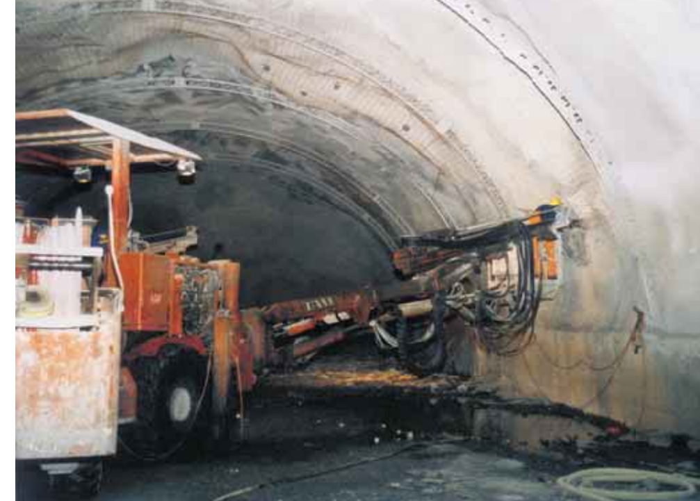
Lavori al data logger con carro di perforazione Jumbo
