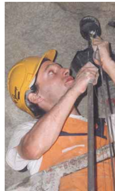
Installation eines Extensometers
